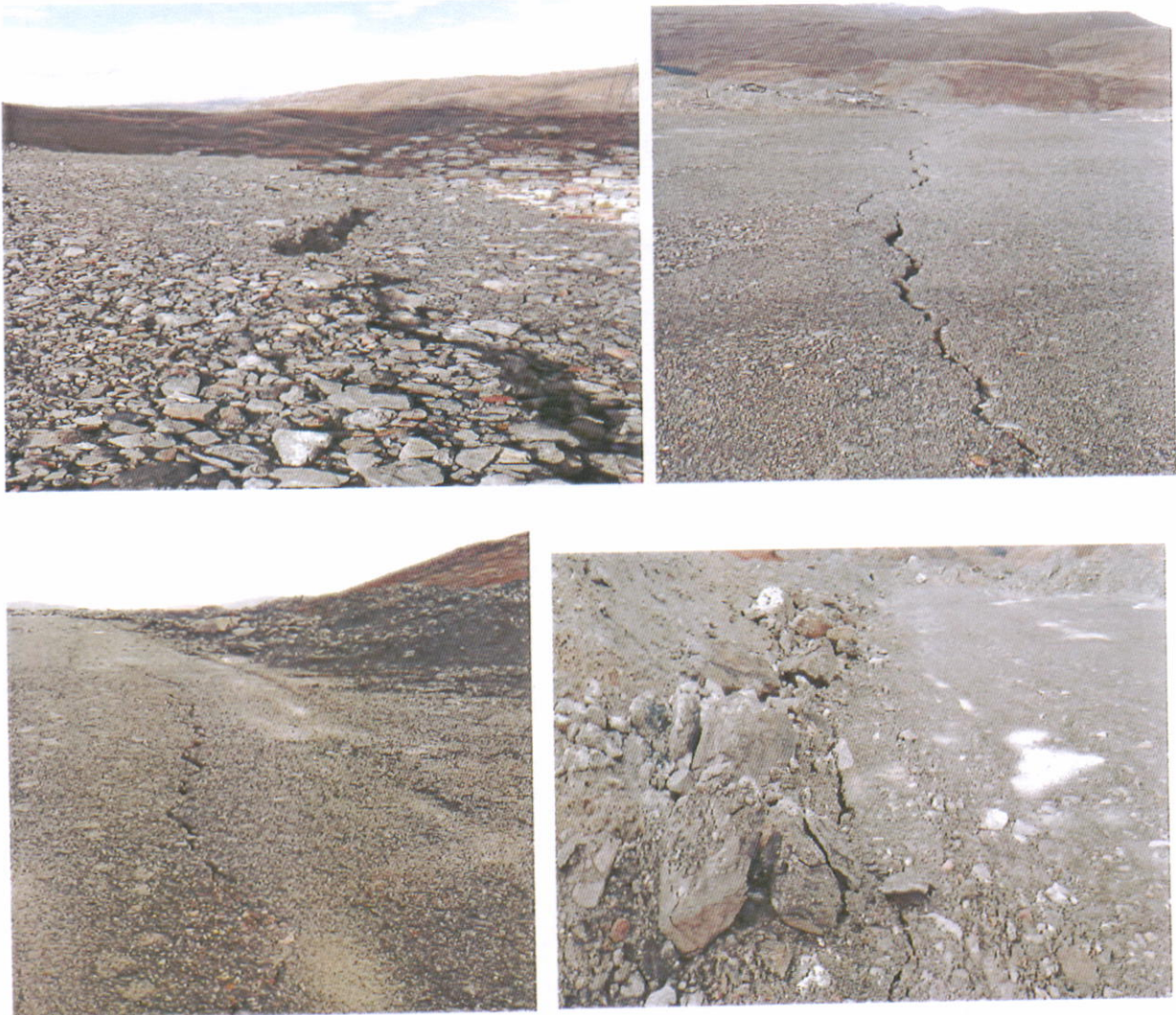
Fotoğraf.6 Güncel pasa üzerindeki tensiyon çatlakları.
