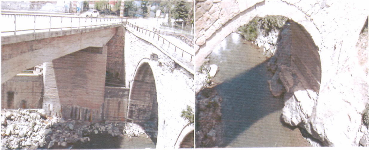
Fotograf 12: Eski ve yeni köprüde meydana gelen hasarlar.
