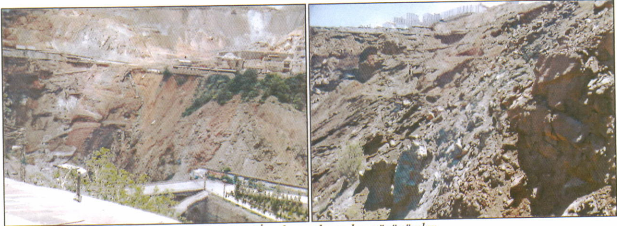
Foto 1-2: İnceleme alanından görünüm.
